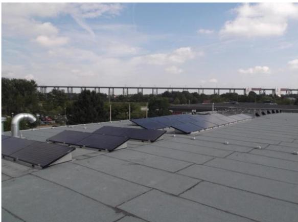
Photovoltaikanlage auf dem Schuldach. Lehreffekt durch verschiedene Ausrichtungen.
